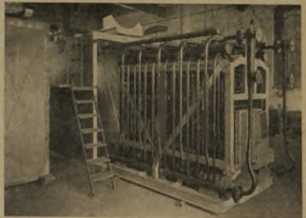
Abb. 5. Schmidt-Hartmann-Hochdruckkessel mit herausgezogenem Erstteil.
