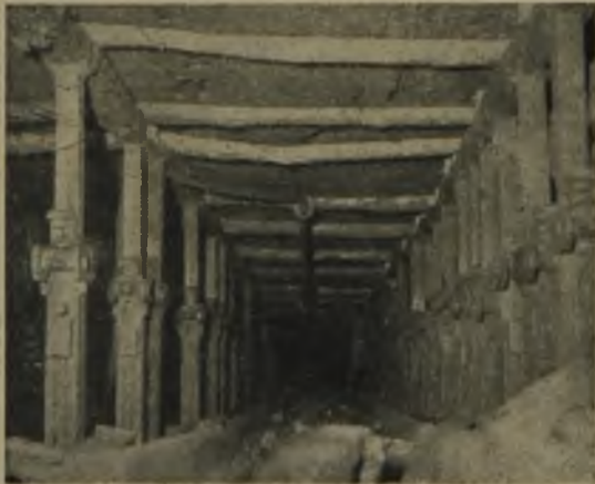
Abb. 5. Reihenstempelbruchbau bei schwebendem Ausbau.
