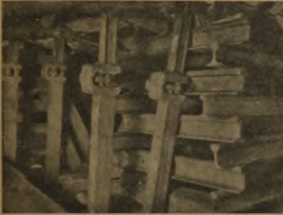
Abb. 3. Strebaubau mit Gerlach-Stempeln und Rundholzkappen.
