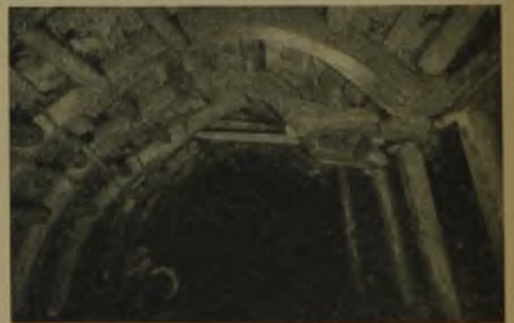
Abb. 11. Die Holzgestelle der 2. Sohle 4-5 Monate nach ihrem Setzen.
