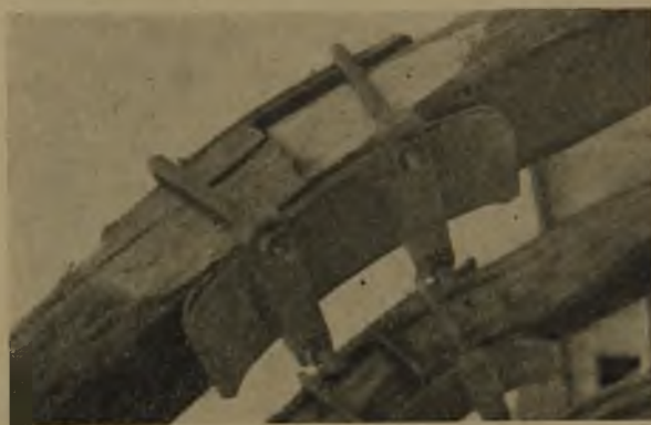
Abb. 6. Verbindung der Kappen und Stempel mit Hilfe von Laschen und Bügelschrauben.
