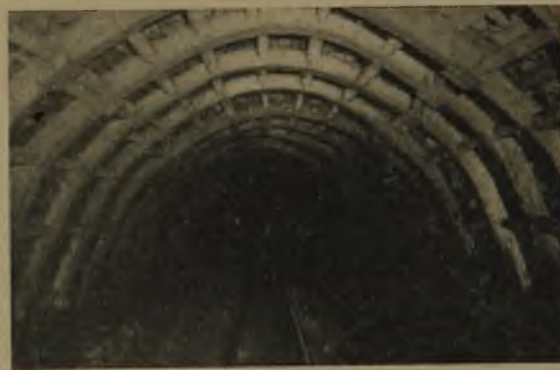
Abb. 7. Die Holzgestelle der Wettersohle. (Bei den vorderen Gestellen sind als Verbindungen Stücke eines Differdinger-Trägers verwandt).
