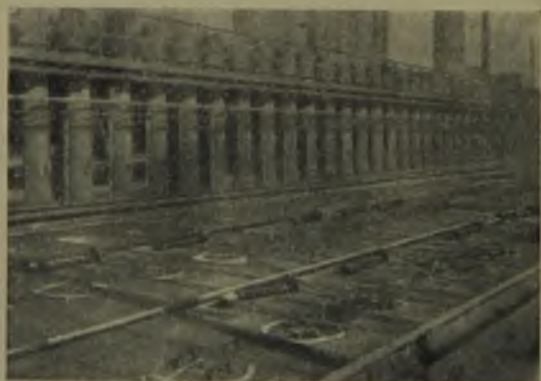
Abb. 11. Spiralverdampfer auf Koksofengruppe.
