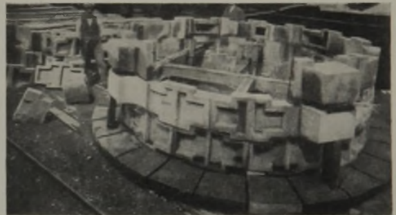
Abb. 5. Aufbau des Ausbaus in Betonformsteinen über Tage.
