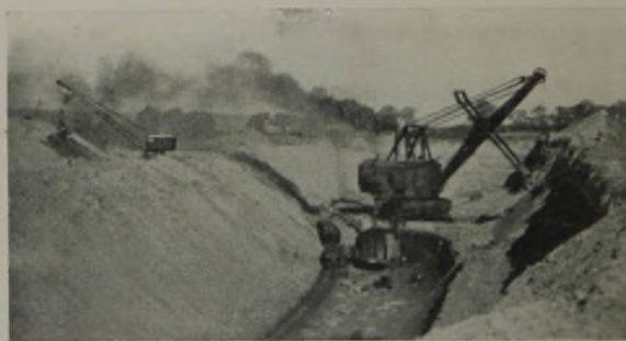
Abb. 4. Tagebau auf dem Northampton-Flöz bei Irchester mit 15 m Abraum- und 2,5 m Erzmächtigkeit.
