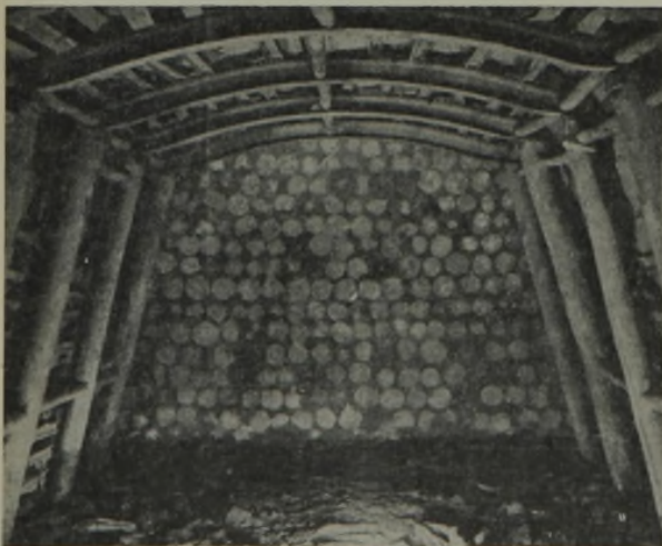
Abb. 3. Lehmknüppeldamm in einem zweispurigen Querschlag.
