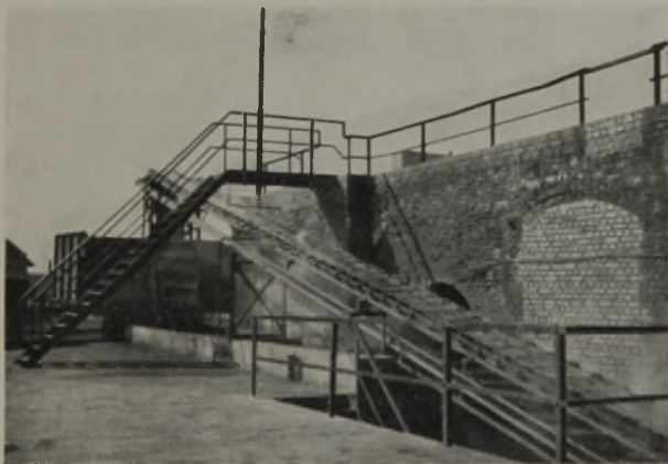
Abb. 10. Gliederband zur Überführung des flüssigen Hartpechs in die feste Form.
