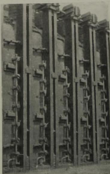
Abb. 2. Koksofentüren mit Einrichtungen für die Innenabsaugung durch die Kammertüren.
