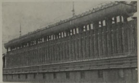
Abb. 1. Maschinenseite einer mit Innenabsaugung durch die Kammertüren ausgestatteten Koksofengruppe.
