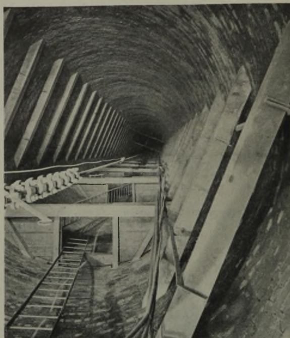
Abb. 8. Blick in den umgebauten Schacht.
