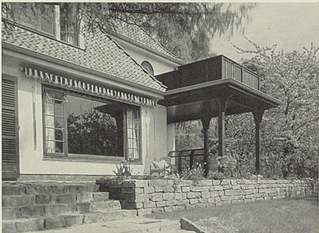
Carl Hermann, Hamburg. Die großen Fenster auf den Fluß und der aus Teak-Holz konstruierte Balkon, zu dem die folgende Zeichnung Einzelheiten zeigt
