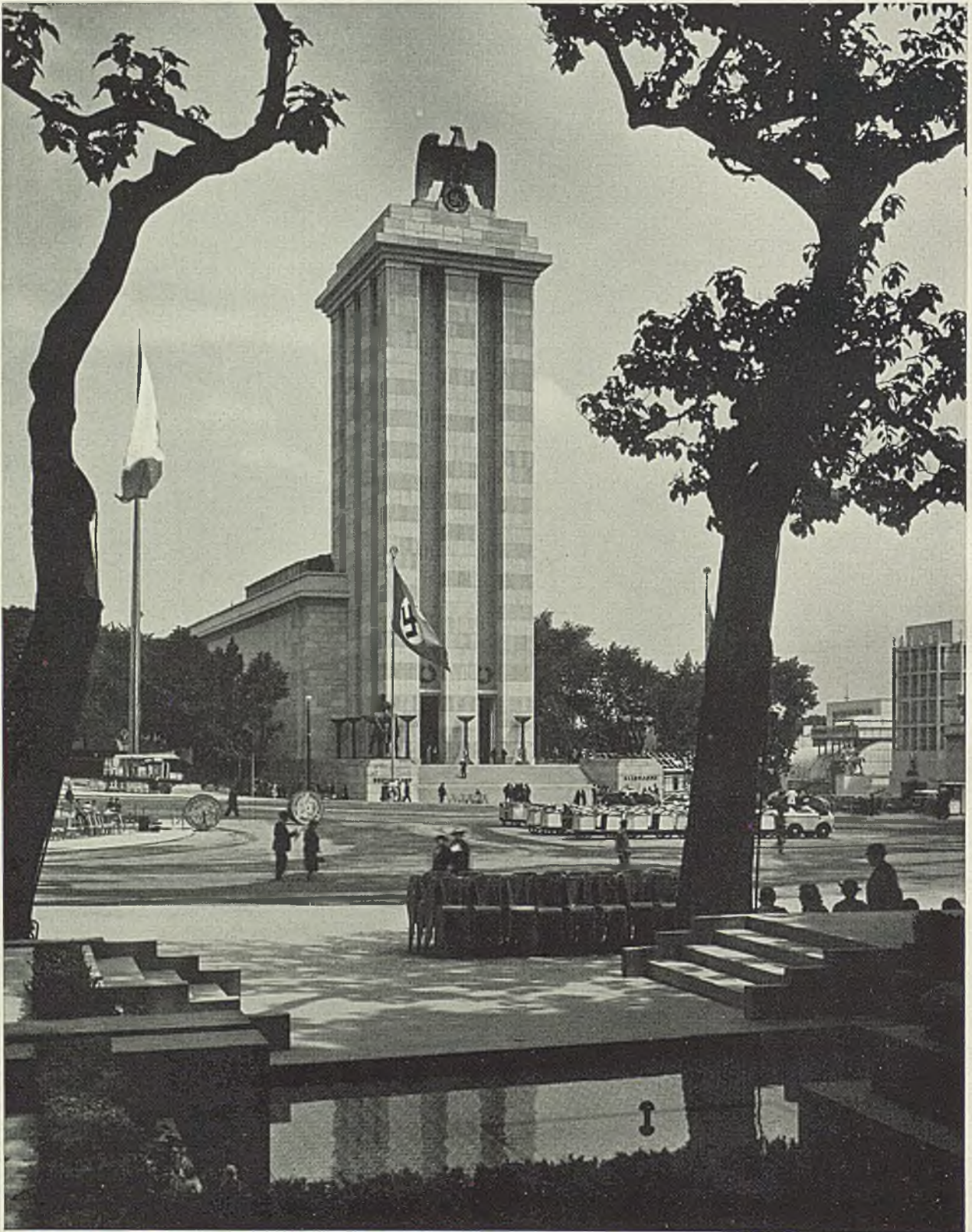
Unser Deutsches Haus, im Äußeren von Albert Speer, im Inneren von W. Brinkmann gestaltet, nimmt als Flankierung des Aufgangs zur Jenabrücke einen der wichtigsten Plätze ein. Auf einem strenggegliederten Turm trägt das bedeutsame Bauwerk das Hoheitszeichen in 55 m Höhe. Die anschließende Ausstellungshalle überbrückt die Avenue de Tokio; sie mißt bei 15 m lichter Höhe 140 m in der Länge und bietet vom Dachrestaurant freien Ausblick über das ganze Ausstellungsgelände. Bauweise Stahlskelett, Verkleidung deutscher Werkstein
