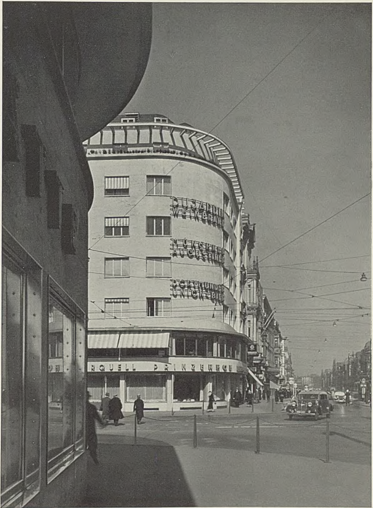
Hans Heinz Lüttgen, Köln. Der Prinzenhof in Köln. Gesamtansicht vom Opernrestaurant aus. Trotz seiner Haut aus geöltem Travertin erkennt man den Skelettbau. Beide Eingänge liegen in Nischen. Die Wohnungstreppe und den Personenaufzug betritt man, wie das Bild gegenüber zeigt, von der Aachener Straße
