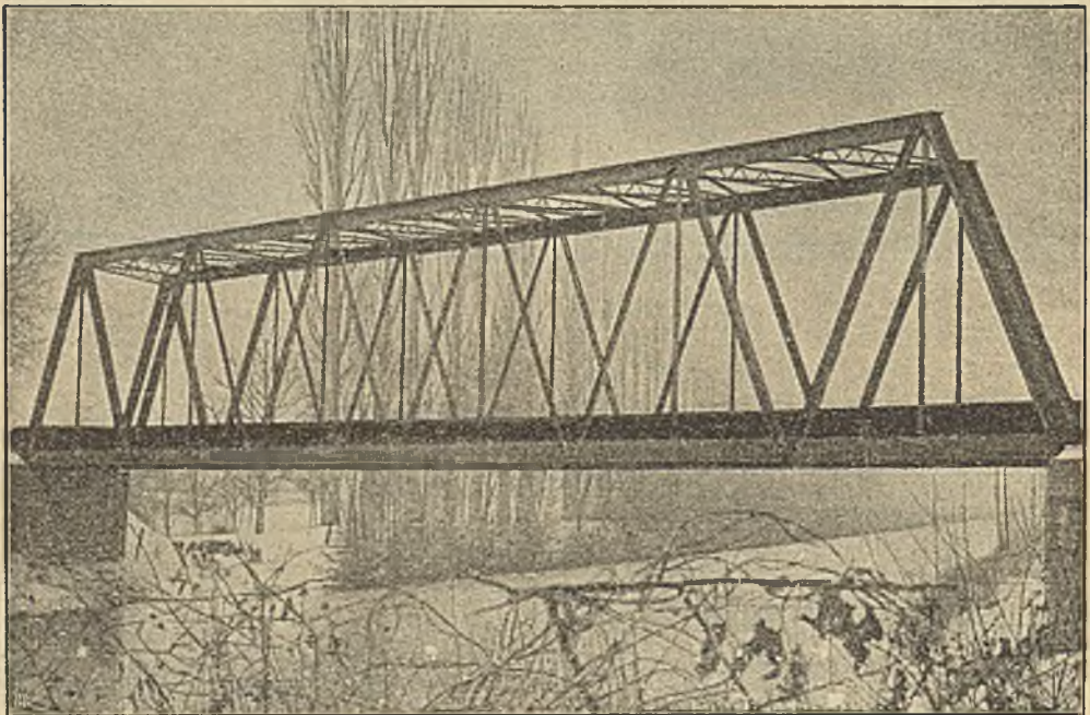
Abbildung 4. Die Brücke vor dem Einsturz.
