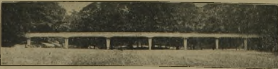
Abb. 5. Ansicht der Abflußleitung bei der Überquerung des Zillertales.
