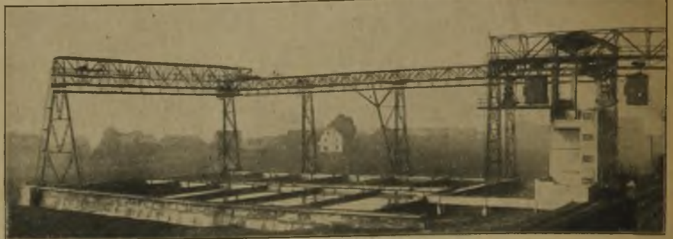
Abb. 2. Ansicht der Kläranlage und des Mischturmes.
