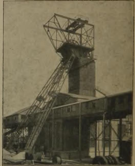
Abb. 6. Einstrebengerüst des Schachtes 2 der Zeche Scholven.
