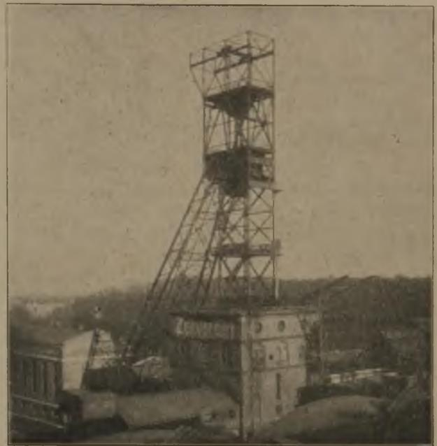
Abb. 9. Einstrebengerüst des Schachtes 2 der Zeche Zollverein mit übereinander liegenden Seilscheiben.
