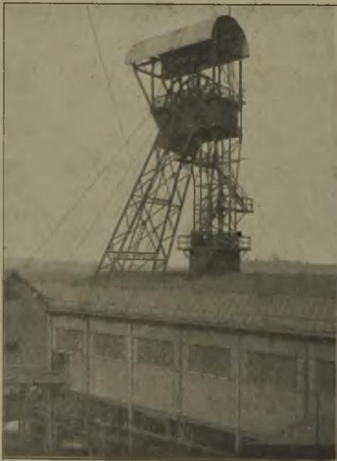
Abb. 5. Einstrebengerüst des Schachtes 2 der Gewerkschaft Sophie Jacoba bei Hückelhoven.
