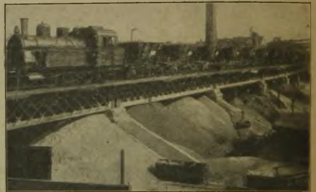
Abb. 4. Spülversatzanlage beim Vertrauensschacht in Schedewitz.
