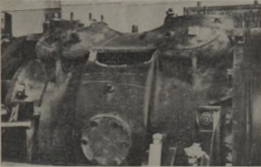
Abb. 11. Durch Wasserschlag zerstörter Dampfmaschinenzylinder.
