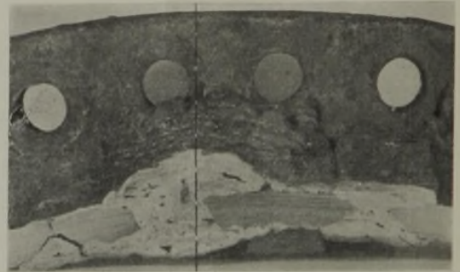
Abb. 4. Schlecht verschweißte Längsrisse an einem Flammrohr im Querschnitt.
