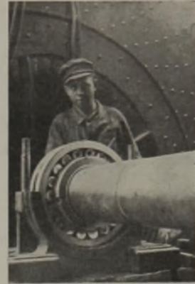
Abb. 35. Lagerung eines Grubenventilators.
