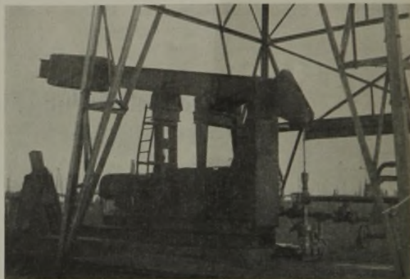
Abb. 7. Tiefpumpe mit Langhub-Pumpenbock.
