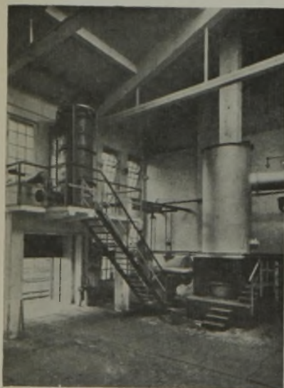
Abb. 2 und 3. Ansicht der Schwefelsäure-Gewinnungsanlage auf der Kokerei Emil.
