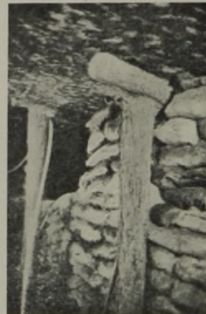
Abb. 5. Bergemauer aus Bergesäcken.
