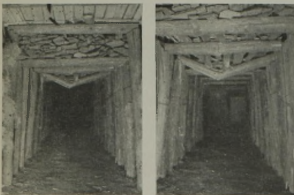
Abb. 10 und 11. Für Brandversuche hergerichteter Rohrkanal auf der Versuchsgrube.
