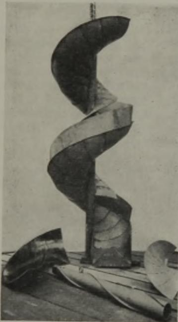
Abb. 3. Ansicht der Wendelrutsche und einiger Einzelteile.
