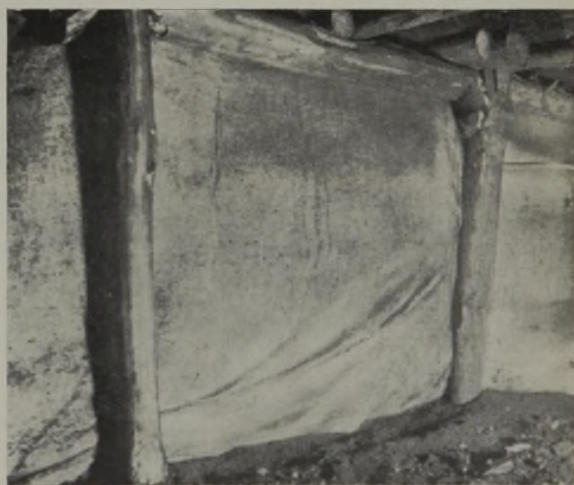
Abb. 1. Tacoleinen (Flöz Blücher mit 1,10 m Mächtigkeit und gebrächem, druckhaftem Hangenden).
