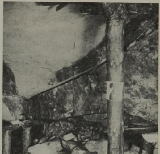
Abb. 17. Flacher Setzriß im Schrämbetrieb.
