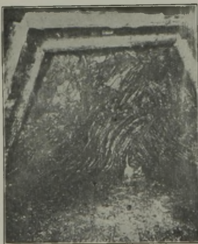
Abb. 31. Einpressung der Liegendschichten in den Hohlraum auf den Schöllerschächten in Kladno (Aufnahme von Spackeler).
