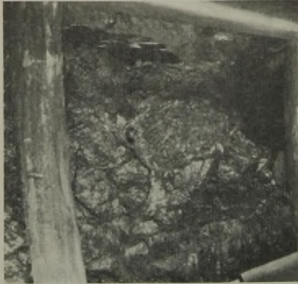
Abb. 8. Drucklagen senkrecht zur Strebrichtung im Flöz Wilhelm der Zeche Hansa.
