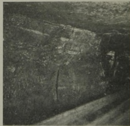
Abb. 10. Aufspaltung am Kohlenstoß mit Drucklagen 1 im oberen Teil des Flözes Blücher 2 der Zeche Hansa.
