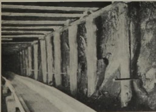
Abb. 1. Abgebohrter Kohlenstoß.
