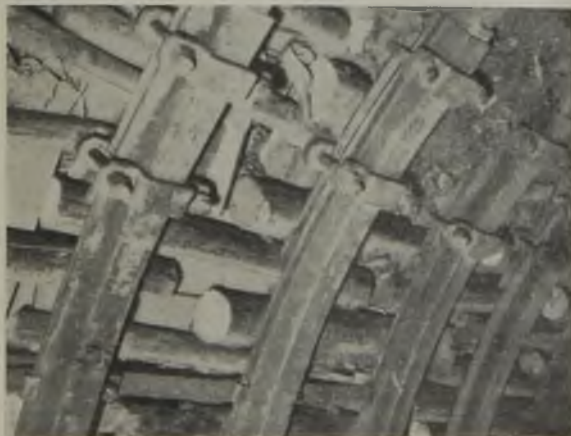
Abb. 12. Klemmfeste Verbindung der Bochumer Hütte.
