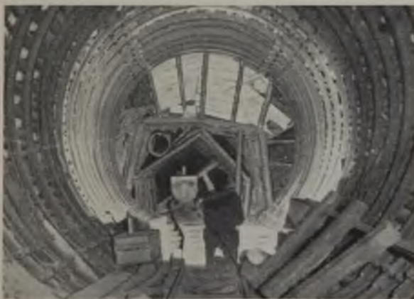
Abb. 9. Geschlossener Bogenausbau in Portalprofil mit klemmfester Verbindung.
