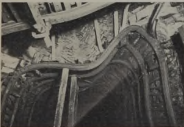
Abb. 18. Verbogener Stahlausbau.
