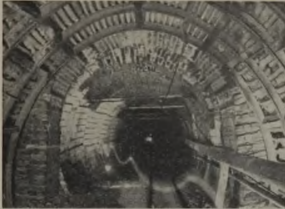
Abb. 14. Starrverlaschtes Pokalprofil mit Wellblechverzug in der Firste.
