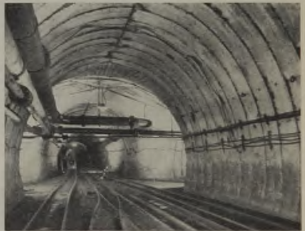
Abb. 5. Ausbau im Dreigelenkbogen von Walter-Henkel.
