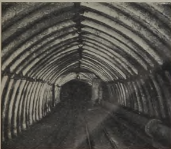
Abb. 3. Betonpolygonausbau mit Quetschhölzern.
