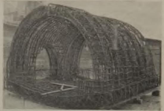
Abb. 4. Eisengerippe des Dreigelenkbogens von Walter-Henkel.
