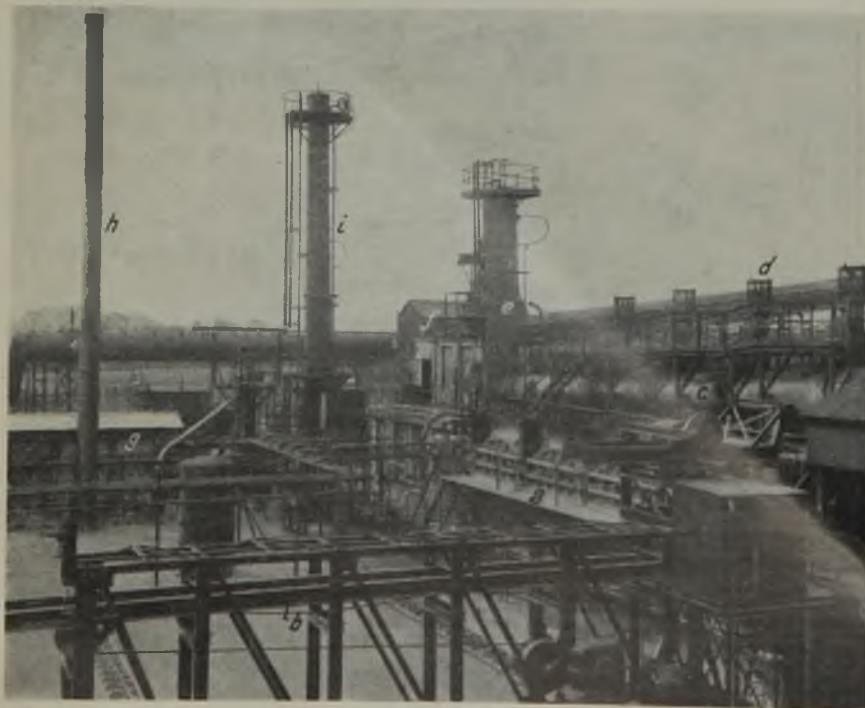
Abb. 4. Ansicht der Ofen- und Druckspaltanlage in Corby.
