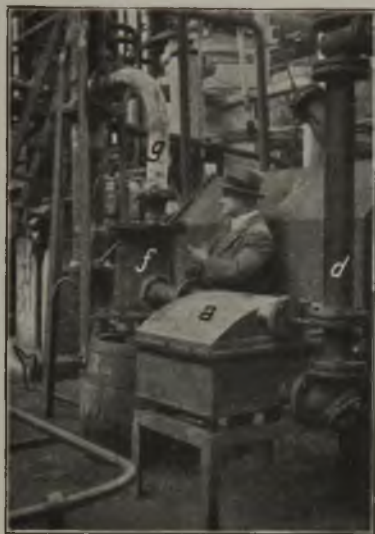
Abb. 2. Versuchsanlage zur Naßentschwefelung für 1000 m 3 Gas täglich.
