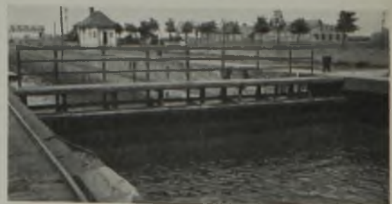
Abb. 11. Das Obertor der nicht abgesunkenen Schleuse V.
