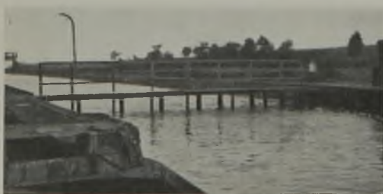
Abb. 10. Das überflutete Obertor der gesunkenen Schleuse IV.
