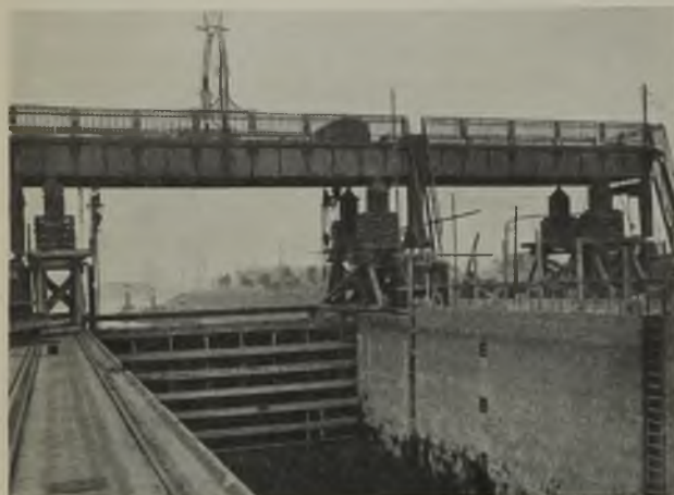
Abb. 13. Hebung der Torbrücke des Unterhauptes der Nordschleuse IV um 2 m.
