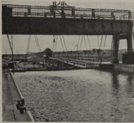
Abb. 12. Drohende Überflutung des Untertores der gesunkenen Schleuse IV.
