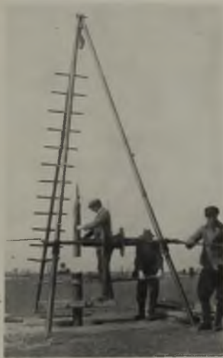
Abb. 5. Gerät für die Herstellung von Flachbohrungen.
