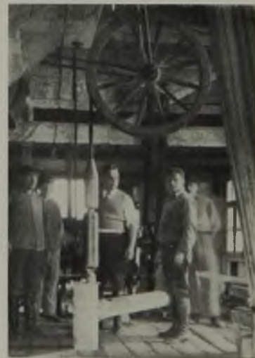
Abb. 3. Einführung des Seismographen in ein Bohrloch.
