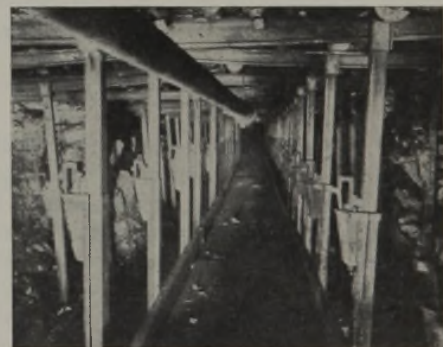
Abb. 13. Blindortversatz, streichender Ausbau mit Schienen.
