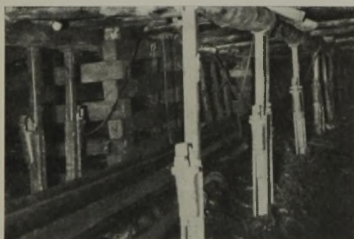
Abb. 14. Teilversatz mit Wanderholzkasten, schwebender Ausbau mit Holzkappen.
