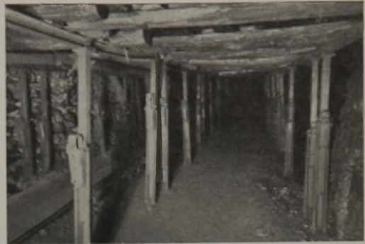
Abb. 11. Vollversatz von Hand, schwebender Ausbau mit I-Eisen.
