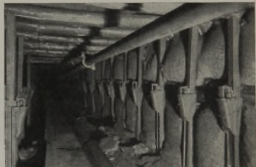
Abb. 12. Blasversatz, ältere Stempelbauart, streichender Ausbau mit Holzkappen.
