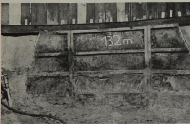
Abb. 5. Oberkante der alten Tübbingsäule.
