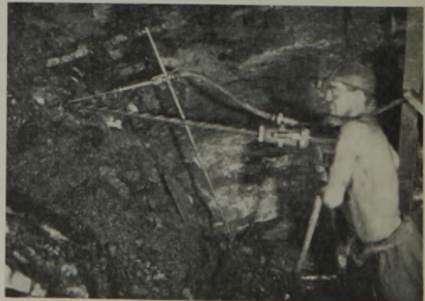
Abb. 4. Einspritzen eines feinen Wasserstrahls in das Bohrloch.
