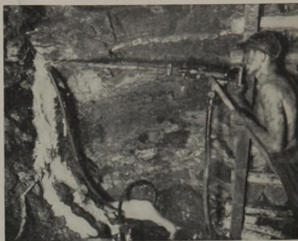
Abb. 2. Bindung des bei der Bohrarbeit entstehenden Staubes durch Schaum.
