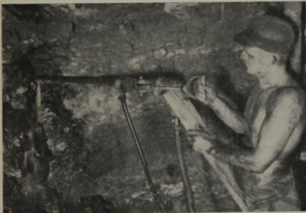
Abb. 5. Naßbohren mit Spülkopf und Hohlbohrer.
