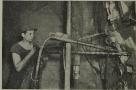
Abb. 3. Bespritzen des Bohrlochmundes mit einem Wasserkegel.
