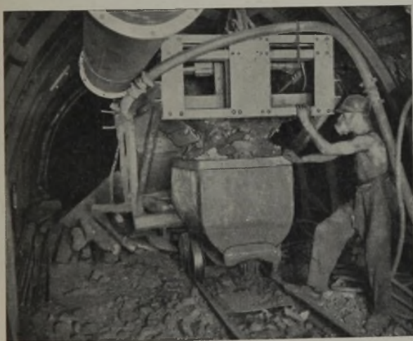
Abb. 1. Anwendung der Staubschutzmaske bei der Ladearbeit mit dem Schrapper.
