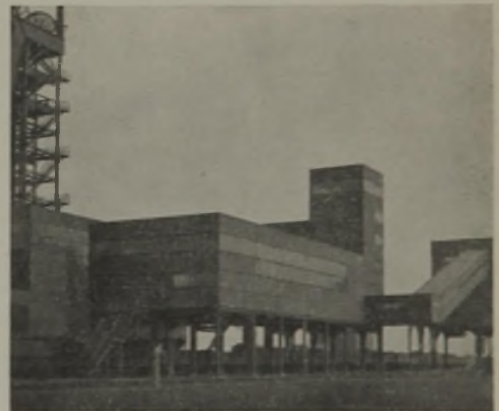
Abb. 1. Kohlensieberei als Beispiel eines Eisenrahmenbauwerkes mit freistehenden Stützen.
