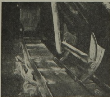
Abb. 21. Auskleidung der Schienen bei Seitenkippern.
