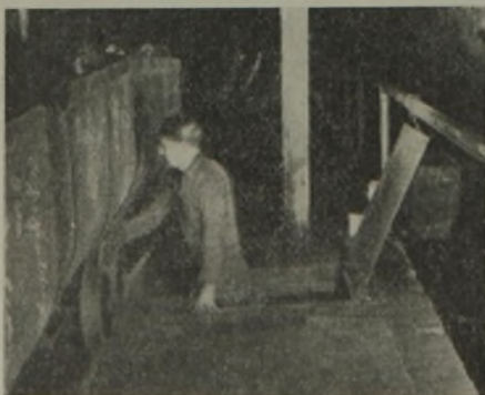
Abb. 14. Grube für den Abknebler.
