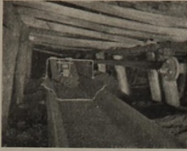
Abb. 25. Bremsvorrichtung in fester Rutsche.
