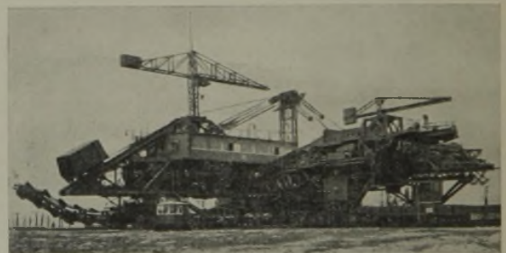
Abb. 2. Rückansicht des in Abb. 1 wiedergegebenen Tiefbaggers mit Beladungsvorrichtung.
