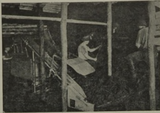
Abb. 9. Ladeband im Abbau.
