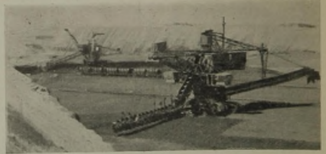
Abb. 8. Eimerkettenschwenkbagger und Schaufelradbagger auf Raupen, in der Kohle arbeitend.
