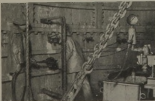
Abb. 4. Tübbinganbohrvorrichtung.
