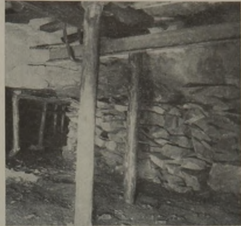
Abb. 1. Nachschießen eines Blindorts im Hangenden.
