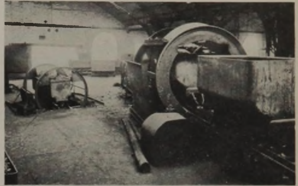
Abb. 3. Selbsttätiger Kreiselwipper für 1750-l-Wagen neben einem Wipper für 800-l-Wagen.
