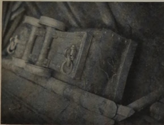
Abb. 2. Einfache Kippeinrichtung für kleine Förderwagen.
