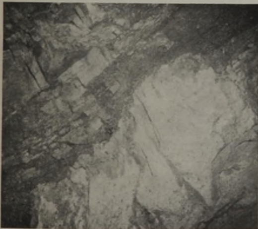
Abb. 10. Hangende Kontaktstelle des liegenden Teiles des Intrusivlagers im Stollen R der Grube St. Ingbert.
