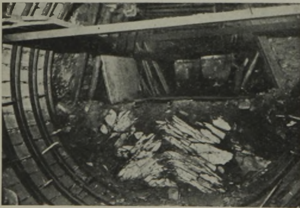
Abb. 8. Bildung der Entspannungzone im Liegenden.
