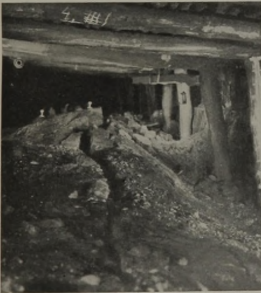
Abb. 5. Westliche Richtstrecke der 3. Sohle nach einem Gebirgsschlage.
