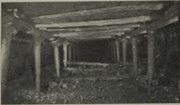
Abb. 7. Mit verstellbaren Sprungstempeln ausgebauter Streb.
