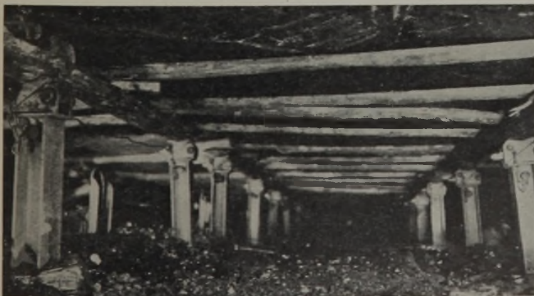
Abb. 2. Sprungstempel älterer Bauart in einem 90-cm-Flöz.
