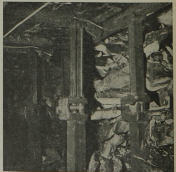
Abb. 6. Reihenstempel mit streichend und einfallend angeordnetem Strebaubau.
