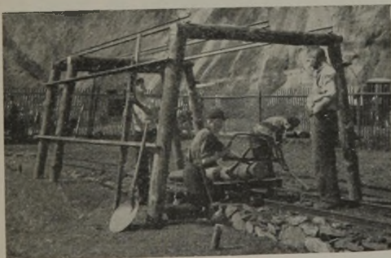
Abb. 1. Vorbereitende Arbeiten für das Setzen des deutschen Türstocks 1 .
