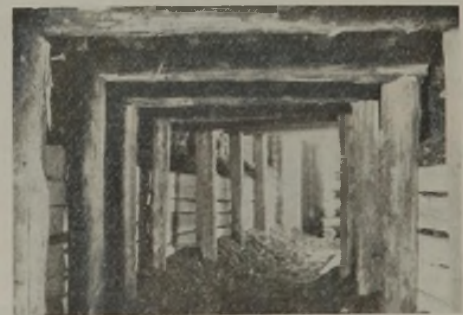
Abb. 3. Ausbau der Versuchsstrecke.
