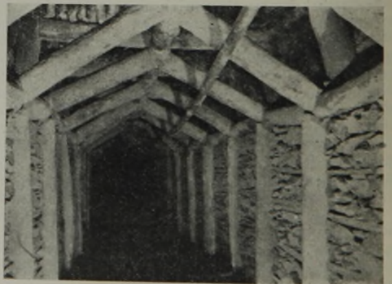
Abb. 2. Ausbau mit Polygonverstärkung.
