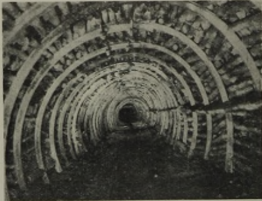
Abb. 6. Sohlenstrecke in Flöz Gustav.
