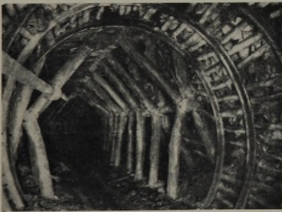
Abb. 4. Übergang vom Türstockausbau mit Polygonverstärkung zu nachgiebigen eisernen Toussaint-Heintzmann-Streckenbögen.
