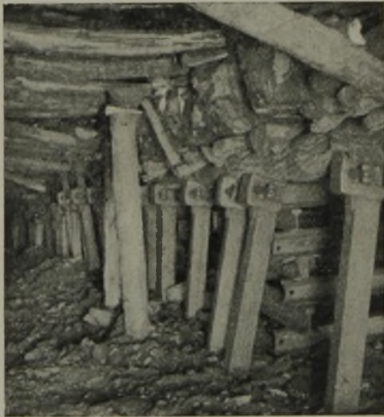
Abb. 3. Versagen von eisernen Wanderpfeilern bei Gebirgsschlägen.
