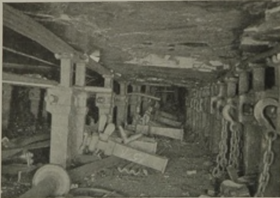
Abb. 10. Blick in einen Strebraum mit gleichbreiten Feldern.
