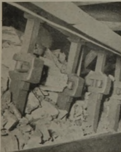
Abb. 8. Hilfsstempel mit Strebe zum Kohlenstoß hin.
