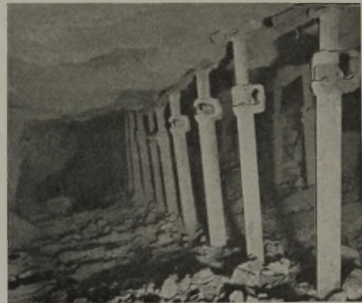
Abb. 16. Ausbau im Doggererzbergbau nach Abb. 2a (Stempelabstand hier 0,6 m im Streichen und Einfallen).
