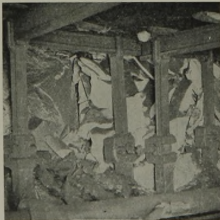
Abb. 4. Bruchfeld bei ungeschichtetem Sandsteinhangendem.
